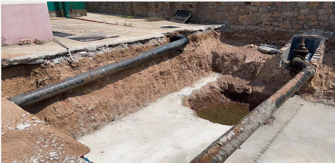
惜福镇水厂小型污水处理系统改管完成
