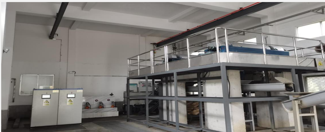
管家楼水厂污泥脱水系统
