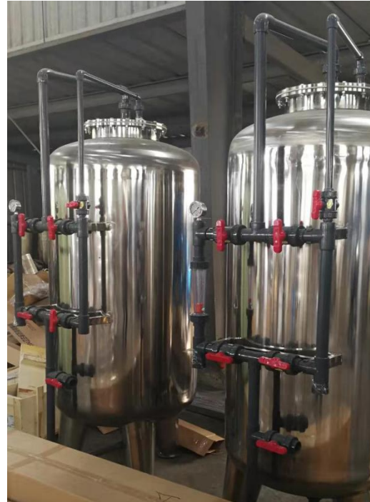
过滤系统装置图（多介质过滤器、活性炭过滤器）
