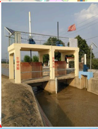
现代化闸门遥控设备 安装闸门远程自动化启闭设备，开展九道堰闸门远程管控
